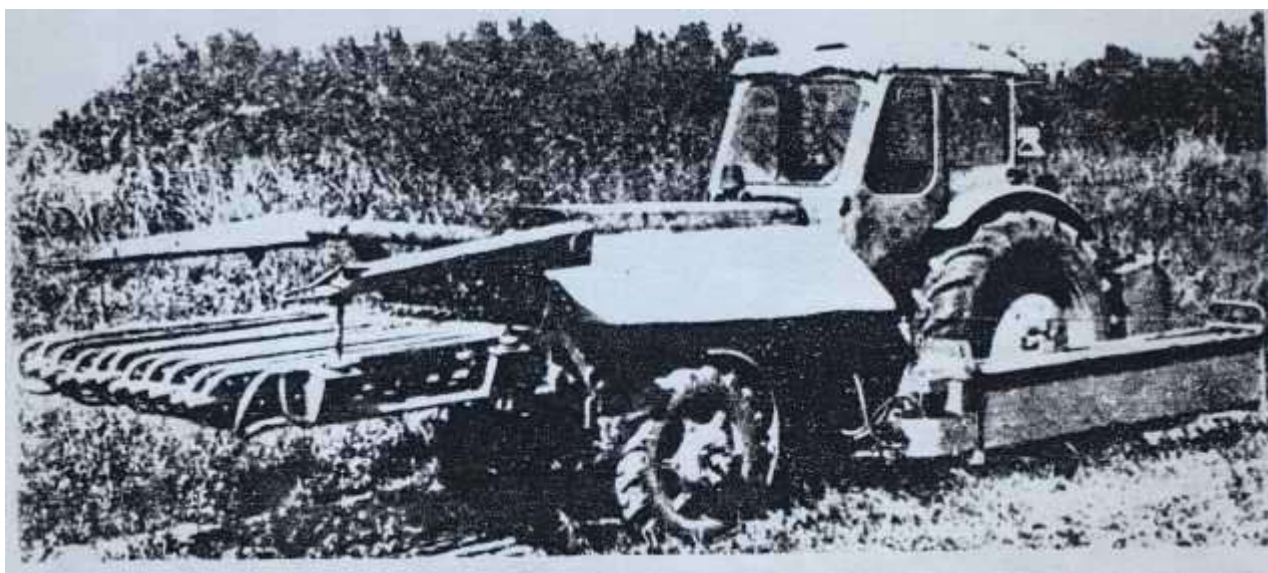
Рис. 5.15. Общий вид машины ФУМ-1 для уборки фундука
