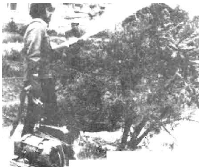
Рис. 22. Замораживание куста струей жидкого хладагента
